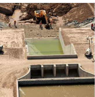
OBRAS DE RECONSTRUCCIÓN
