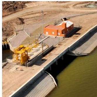
OBRAS DE TOMA
