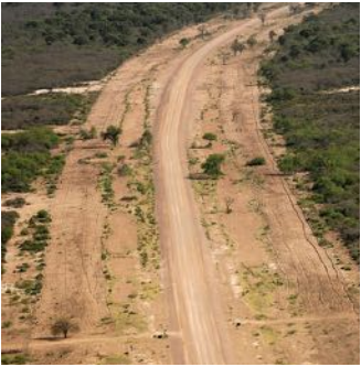
CAMINO DE ACCESO AL DIQUE
