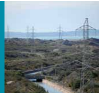
Capítulo 05 LÍNEA DE ALTA TENSIÓN
