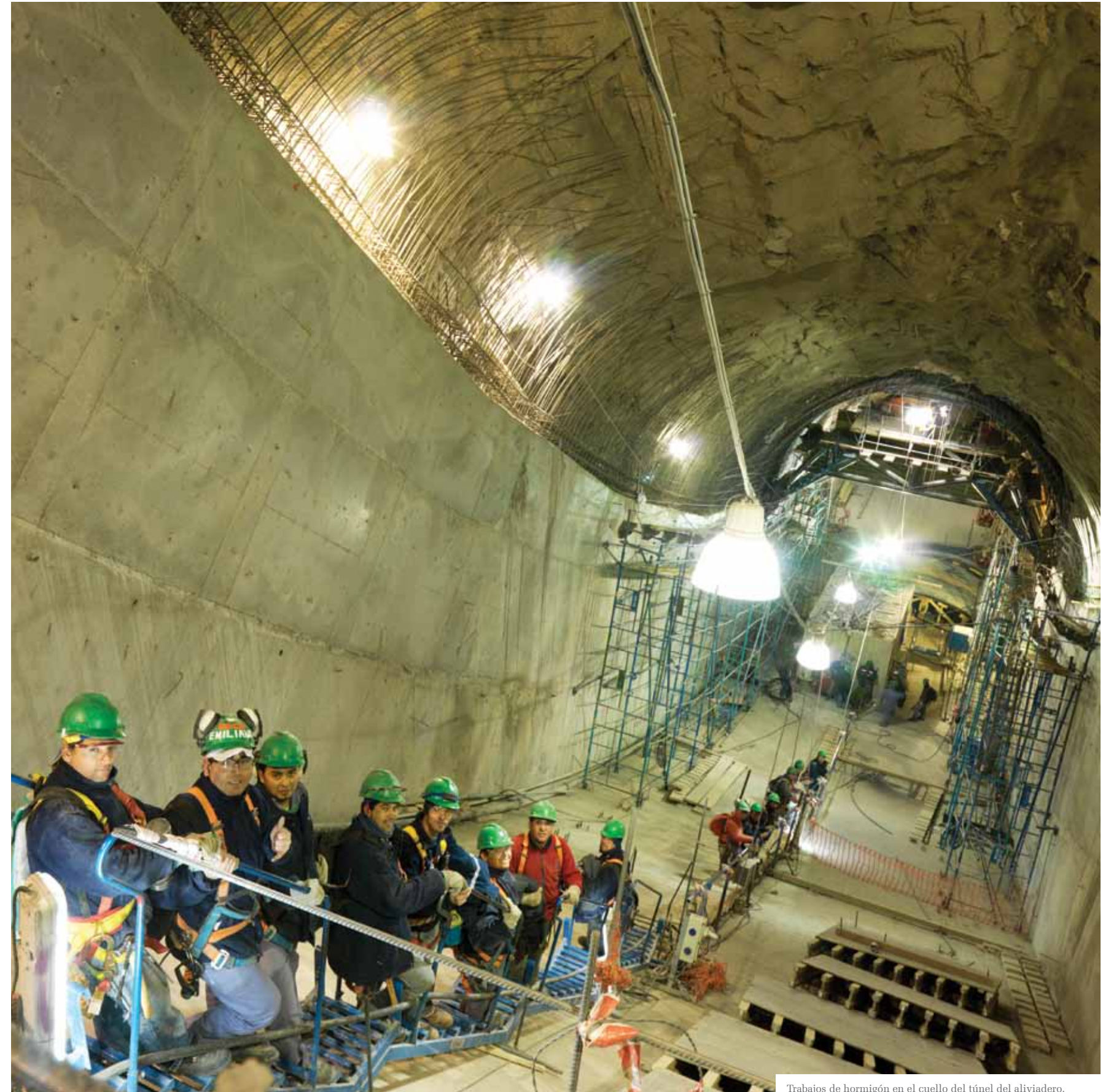
Trabajos de hormigón en el cuello del túnel del aliviadero.
