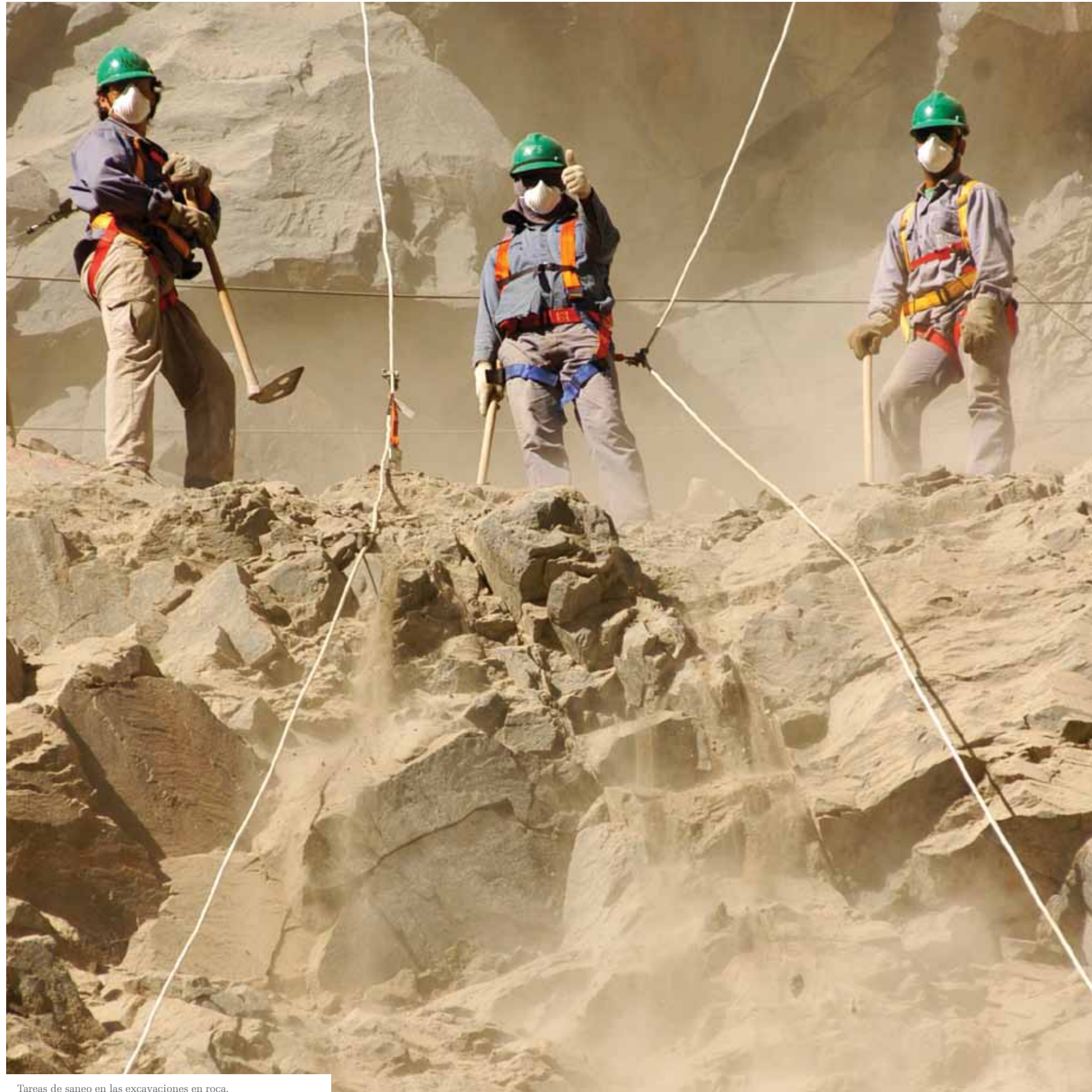
Tareas de saneo en las excavaciones en roca.
